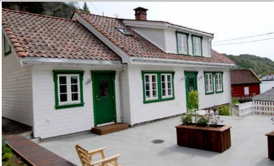
Det er anlagt en trivelig uteplass med sitteplasser foran huset. Her kommer det også utekjøkken
