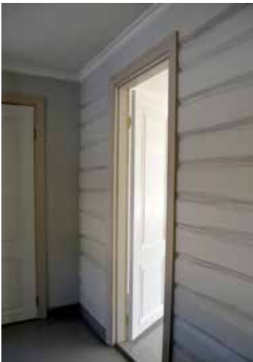
Det ble avdekket fine, gamle tømmervegger som er blitt malt i dusblått
