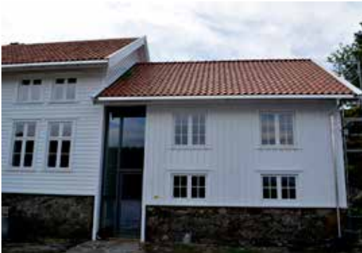
Begge husene er beboelseshus, sammenføyd av en glass-slisse
