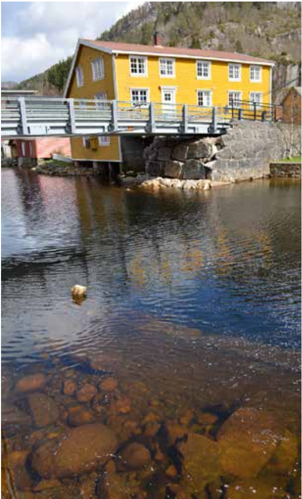
Provisorisk kjørebro. I elva skimtes restene av steinbrygga
